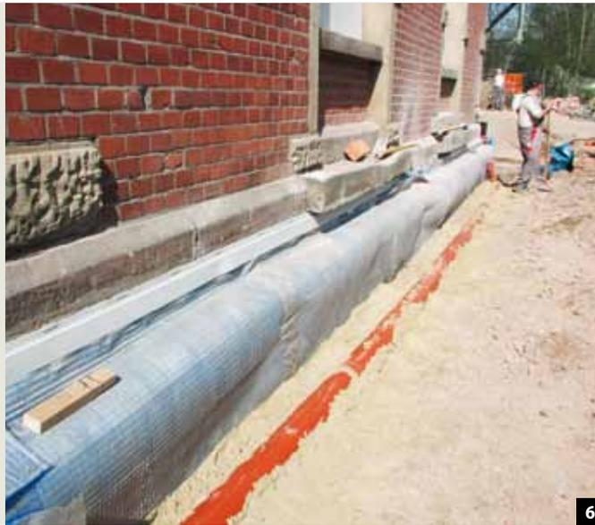
**Abb. 5:** Zur Qualitätskontrolle- und Sicherung wurden die Schichtdicken sowie die saubere Ausführung und die vollständige Durchtrocknung geprüft, bevor weitere Schichten aufgebracht wurden.
