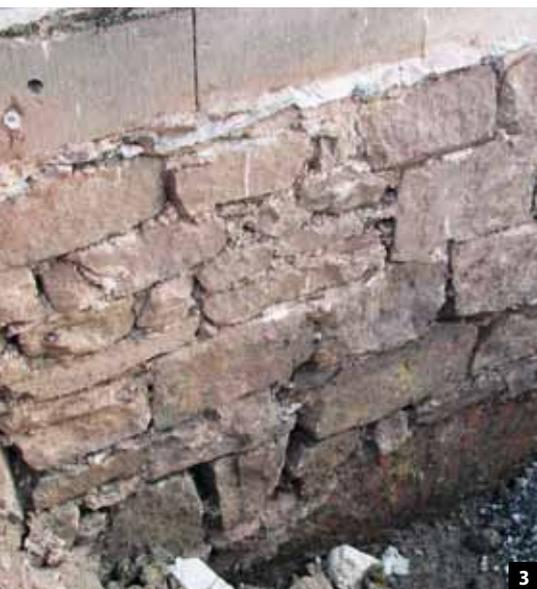
**Abb. 3:** Der vorgefundene Untergrund erforderte die Planung besonderer Vorbereitungsmaßnahmen, da er nicht genormt ist.
