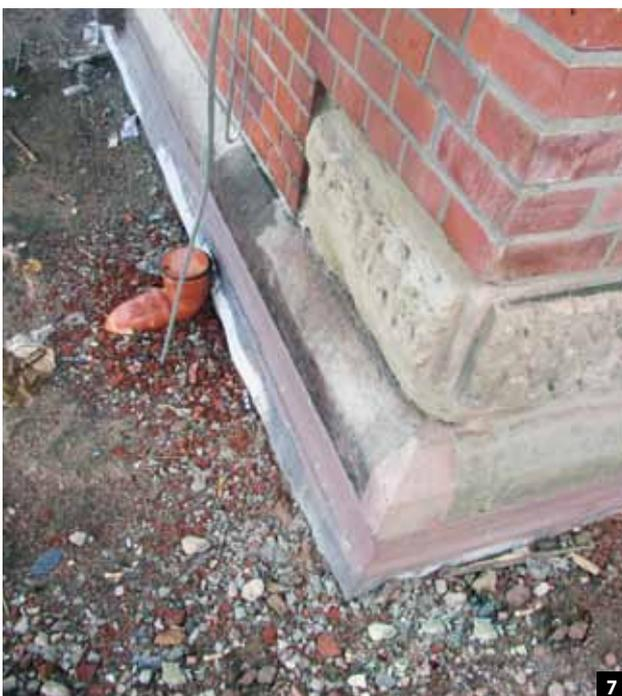
**Abb. 7:** Der Anschluss an den Sockel erfolgte mit einer multifunktionalen Dichtungsschlämme. Die am Objekt durchgeführte Maßnahme ist eine vergleichende Bauweise gemäß der DIN 18195-4. Eine Bauwerksabdichtung gegen nicht stauendes Sickerwasser einschließlich einer Dränanlage nach DIN 4095 wurde ausgeführt.
