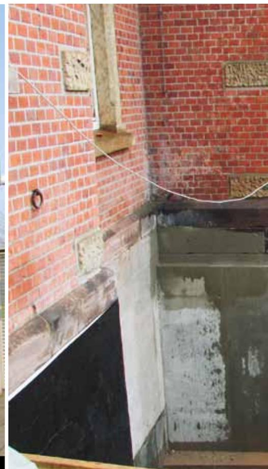
**Abb. 1/2:** Am Bahnhof Friedland wurde eine nachträgliche erdberührte Bauwerksabdichtung mit einer System – Garantie durchgeführt.
